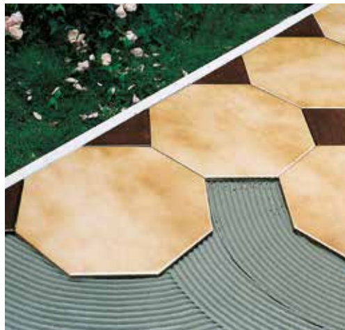
Posa di pavimento esterno
