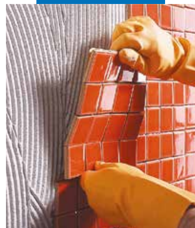
Posa a rivestimento di mosaico ceramico
