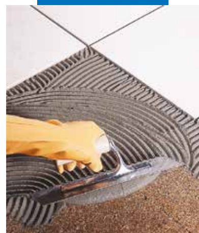
Posa a rivestimento di piastrelle in monocottura su sughero
