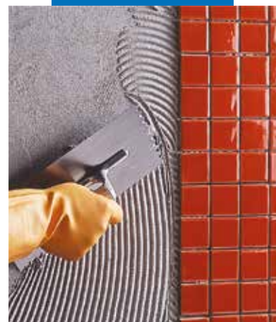
Posa a rivestimento di mosaico ceramico
