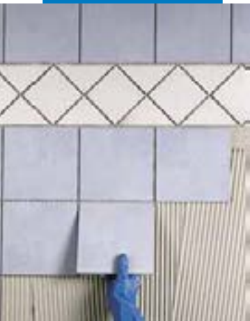
石膏板墙铺贴单烧 瓷砖
