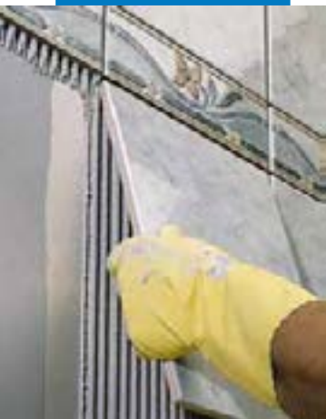
墙面铺贴单烧瓷砖
