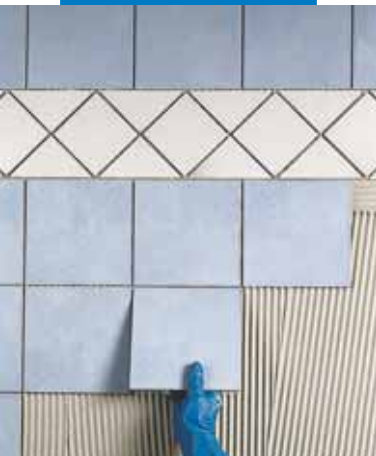
Polaganje jednom-pečenih pločica na zid od gipsanih ploča
