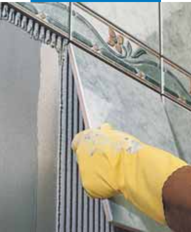
Polaganje jednom-pečenih pločica na zid od malterisan zid
