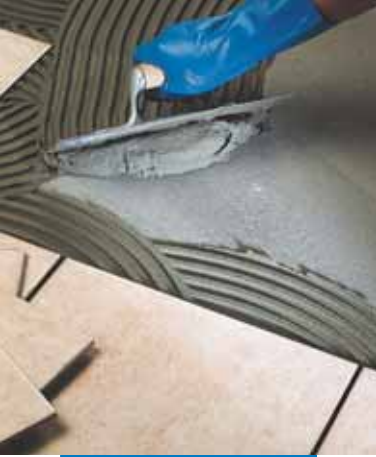
Polaganje jednom-pečenih pločica na pod
