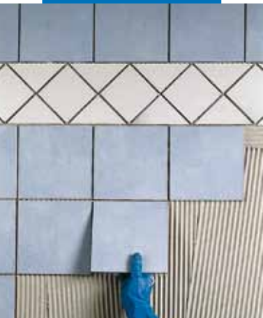
Τοποθέτηση μονόπυρου πλακιδίου σε τοίχο από γυψοσανίδα
