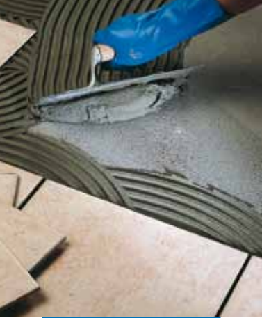
Τοποθέτηση μονόπυρου πλακιδίου σε δάπεδο
