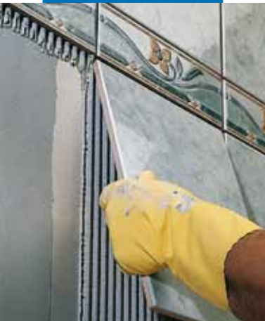
Τοποθέτηση μονόπυρου πλακιδίου σε επιχρισμένο τοίχο
