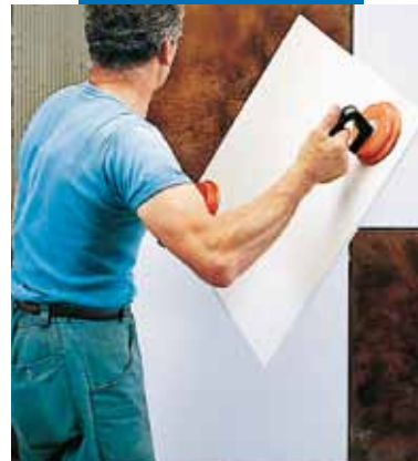
Bir duvara KERAION cephe sistemi döşenmesi
