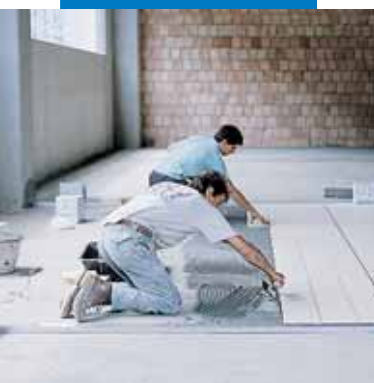
Polaganje porculaniziranog gresa u tvornici
