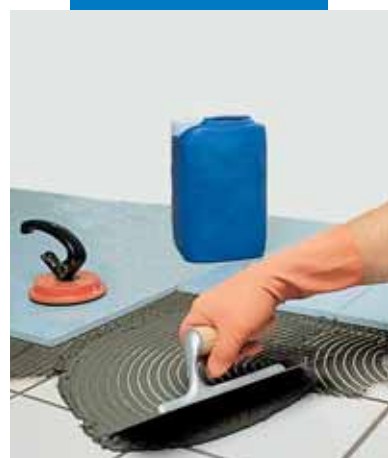
Polaganje velikih ploča na postojeće keramičke pločice sa sivim Granirapid-om
