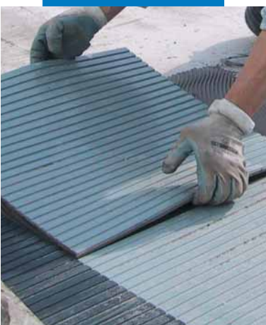
Polaganje gume sa udubljenjem lastin rep, sa Granirapid-om
