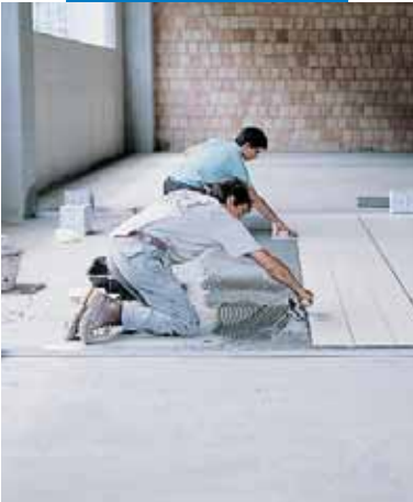
Polaganje porcelanskih pločica u fabrici
