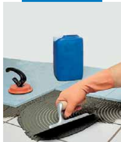
Polaganje pločica preko postojećih keramičkih pločica sa sivim Granirapid-om
