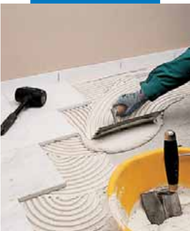
Polaganje belog Carrara mermera sa belim Granirapid-om
