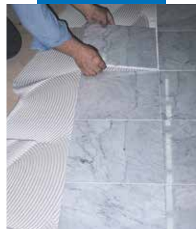
Postavljanje mermera Carrara na drvenu podlogu belim Keralastic-om
