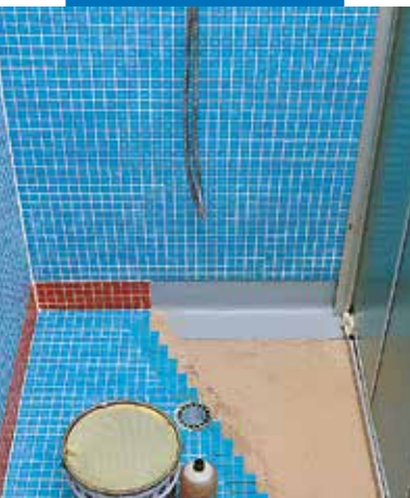
Hidroizolacija i lepljenje u prefabrizovanom kupatilu
