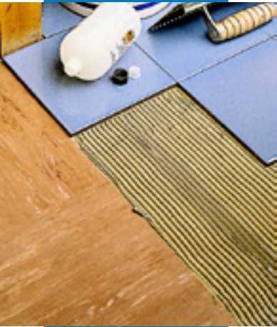
铺设瓷砖在PVC地板
