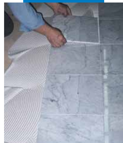
Posa di marmo di Carrara su supporto in legno con Keralastic bianco
