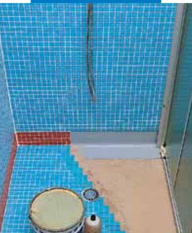
Impermeabilizzazione e posa in box-doccia prefabbricato
