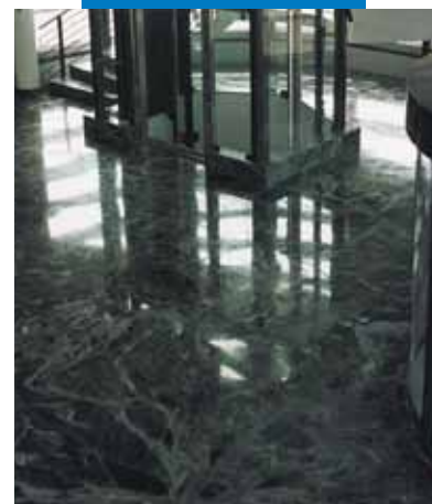
Pavimentazione in marmo verde Alpi realizzata nella hall di ingresso della Rolex (Bienne - Svizzera)
