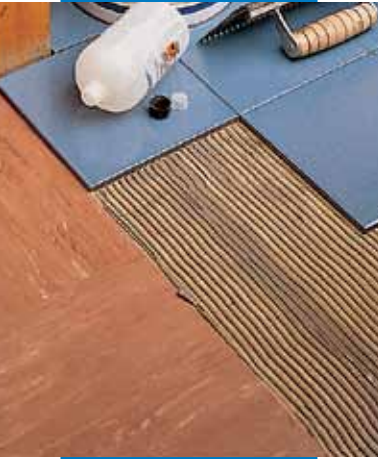
Posa su vecchi pavimenti in PVC
